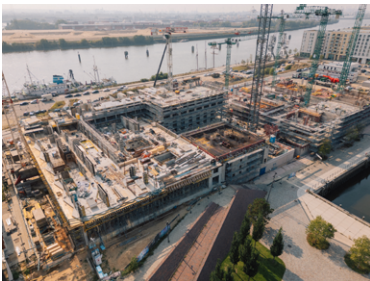
Die Baustelle am Amerigo-Vespucci-Platz
